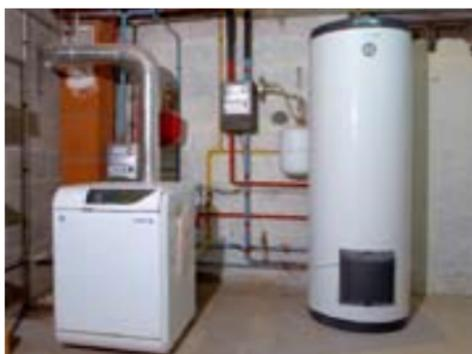
*Dans les systèmes indépendants* (ballon, chauffe-bain ou chauffe-eau), l'eau sanitaire est chauffée par un système autonome : une résistance électrique, un brûleur (au fioul, au gaz naturel ou au propane), des capteurs solaires thermiques ou une pompe à chaleur.
