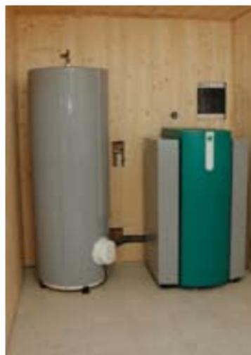
*L'aspect d'une pompe à chaleur géothermique et de son ballon d'eau chaude est assez proche de celui d'une installation de chauffage classique avec chaudière*
